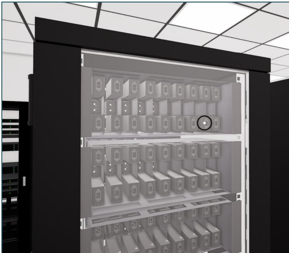
**Для информации.** При условии, что телекоммуникационный шкаф имеет расстояние между передними и задними профилями не менее 700 мм, то в этом случае, можно на передних профилях закрепить шасси RACK-1 с установленными в нем IP-KVM передатчиками/приемниками, а строго за ним, на задних профилях закрепить другое шасси RACK-1, с установленными в нем блоками и коммутаторами питания, которые будут обеспечивать электропитание этих IP-KVM устройств.
